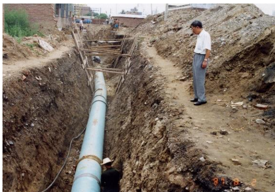
在北京天然气管道埋设现场---焊口 现场补环氧涂层（1997年）
