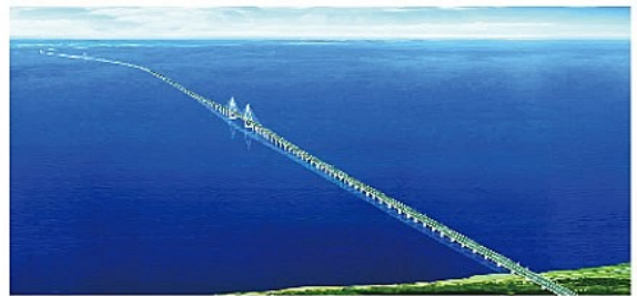
杭州湾跨海大桥防腐工程
